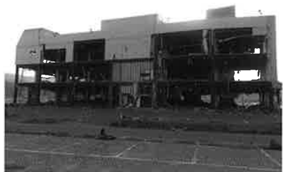
津波の被害にあった建築物
