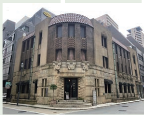
電線の地中化で、より映えた芝川ビルの外観
