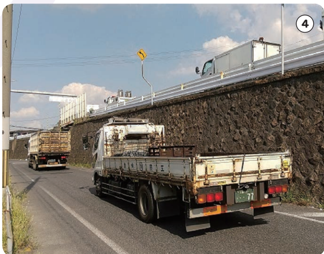
鶴見橋跨線橋、半世紀を隔てての定点対比
