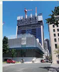
工事現場の外観
