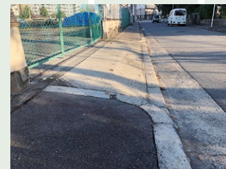
道幅が狭く、傾斜した歩道
