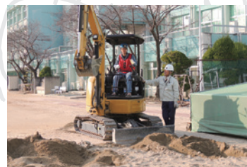
小型建設機械の実技講習会の様子
