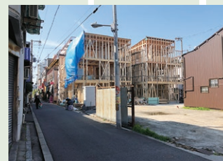
新築3階建ての木造建物の骨組み
