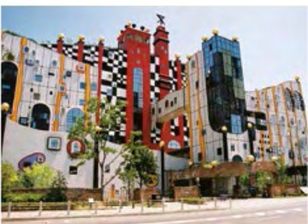
(写真1. 舞洲ごみ焼却工場の写真)
