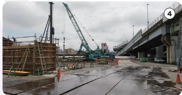
工事中の貨物ヤード跡。この広い空も、もうすぐ見納めとなる
