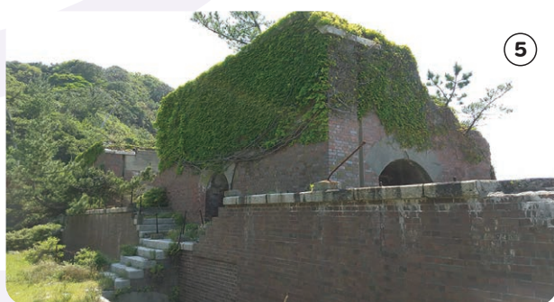
友ヶ島第2砲台跡。保存状態は良いが、所々に爆破の跡があった
