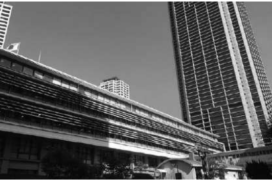
神戸市役所本庁舎(右)1号館(左)2号館
