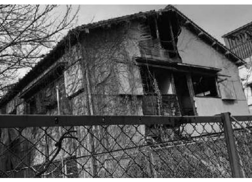
旭地域周辺の空き家
