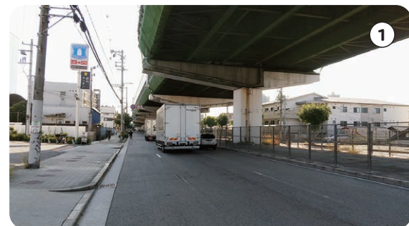
昔の海岸線に沿う阪神高速堺線。津守2丁目から住吉方面を望む
